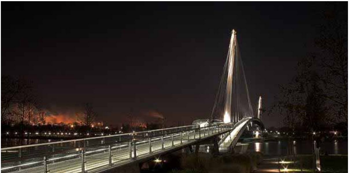
"Passerelle des deux rives", die Rad- und Fußgängerbrücke zwischen Kehl und Straßburg, wurde 2004 zur Landesgartenschau in Kehl zur Verbindung der beiden Grünzonen in Kehl und Straßburg eingeweiht. Bild: Wikimedia Commons (CC-Lizenz)/ Markus Braun
